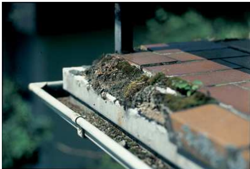
BU: Extreme Temperaturschwankungen, Frost und Regen setzen dem Balkon im Lauf der Zeit stark zu.
